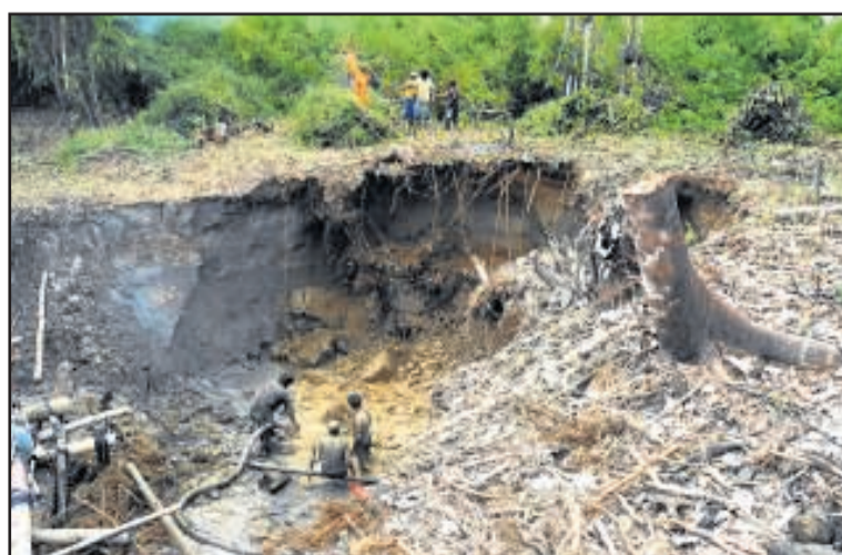
Des conditions de travail apocalyptiques... PHOTO ASS. HUARAYO
